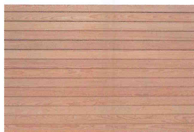
Fatada din lemn pozitionat orizontal de 200mm latime
